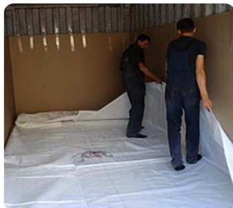
Рис. 4. Вирівнювання положення флексітанка в контейнері та підготовка флексітанка для встановлення щита
